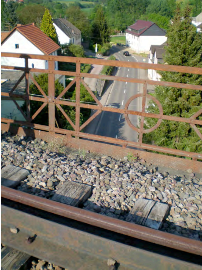
Bild 18: Detailansicht Viadukt Eiweiler
