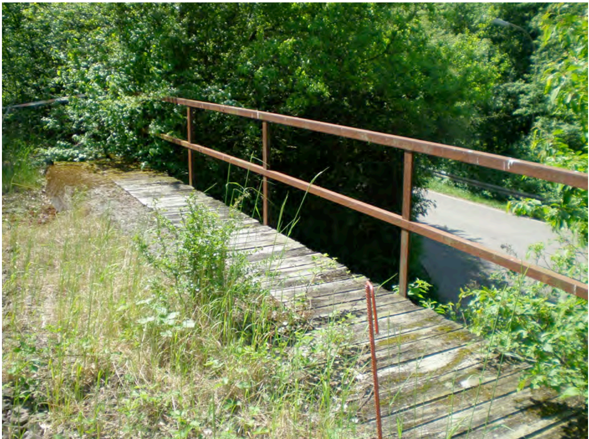
Bild 13: Überführungsbauwerk Winterscheidter Straße von oben
