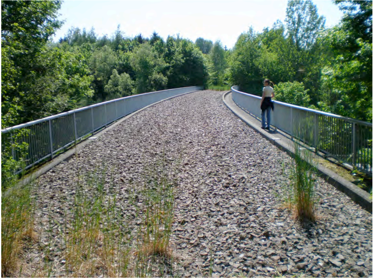
Bild 14: Autobahnbrücke beim Haltepunkt Heusweiler Kirschhof
