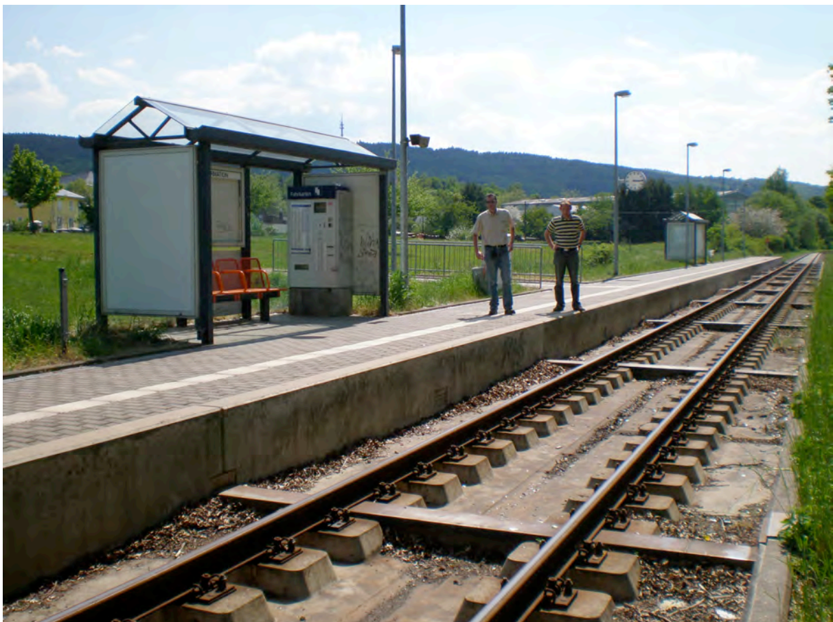
Bild 25: Bahnhof Lebach – Jabach (Endstation)
