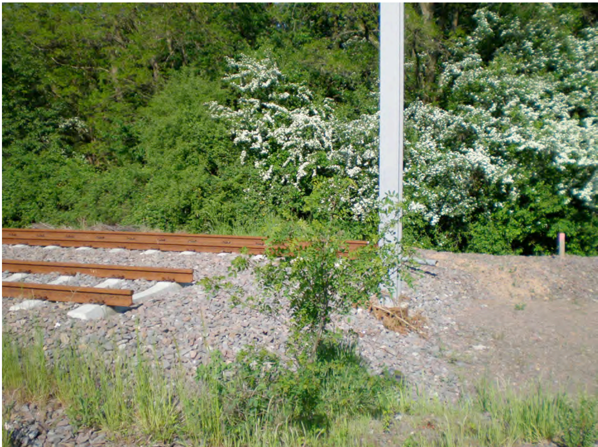
Bild 1: derzeitiges Bauende in Etzenhofen
