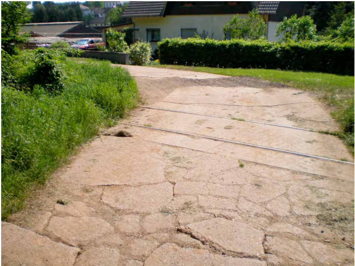
Bild 22: Gleisüberfahrt Landwirt Bauer
