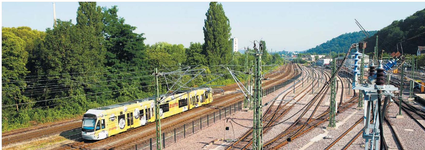
Ein Zaun trennt die Bereiche zwischen der regulären Fahrstrecke (links) und der sogenannten Abstellung auf dem Werkstattgelände.
