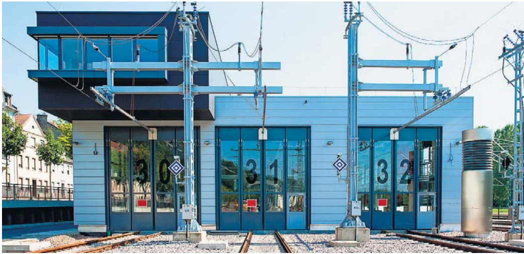
Links: Die nördliche Zufahrt der neuen Stadtbahn-Werkstatt. Auf der rechten Seite ist der „Kanadische Brunnen“ zu erkennen, mit dessen Hilfe Frischluft zur Gebäudebelüftung angesaugt wird. Rechts: Michael Irsch (links), Bereichsleiter Technik und Betrieb Bahn, und Jürgen Welsch, zuständig für die Abwicklung der Baumaßnahmen.
