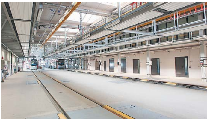
Blick in die Werkstatt: Insgesamt finden hier fünf Stadtbahn-Fahrzeuge Platz.
