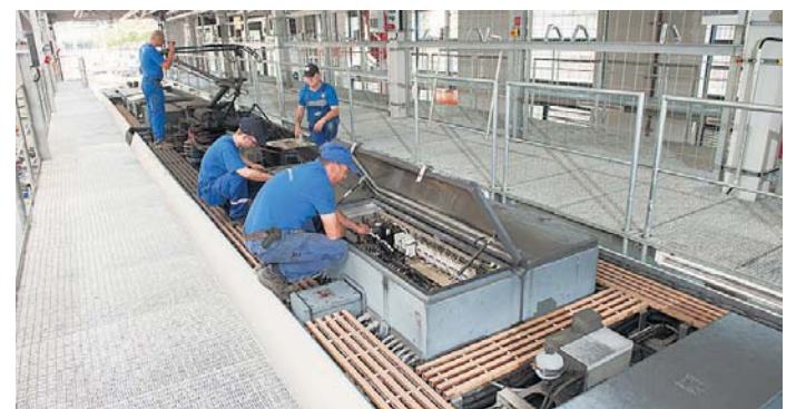
Das Werkstatt-Team der Stadtbahn bei gemeinsamen Arbeiten auf dem Fahrzeugdach. Hier befinden sich unter anderem die Stromabnehmer und die Klimaanlage.
