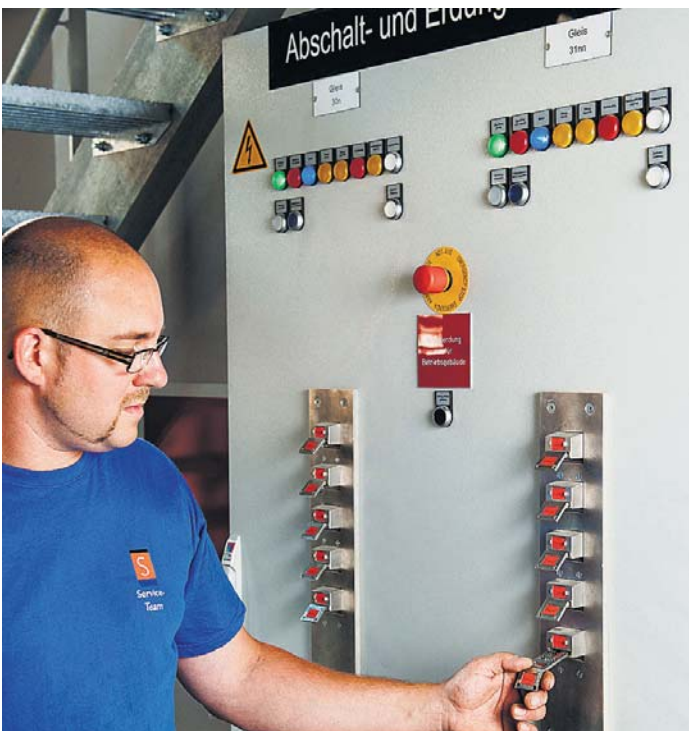
Die AEA macht die Arbeit in der Werkstatt erheblich sicherer.
